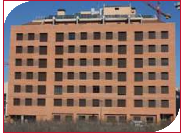
Edifício de Apartamentos em Madrid (Espanha)
